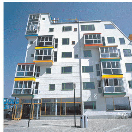
Construline, Västra hamnen i Malmö.
